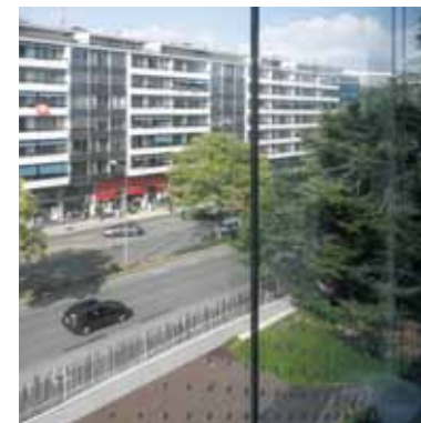
➤ Vue depuis le bâtiment sud vers la rue de Lausanne à l'ouest
