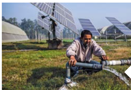
Bombeo de agua subterránea con energía generada por paneles solares en Jagadhri (India).
