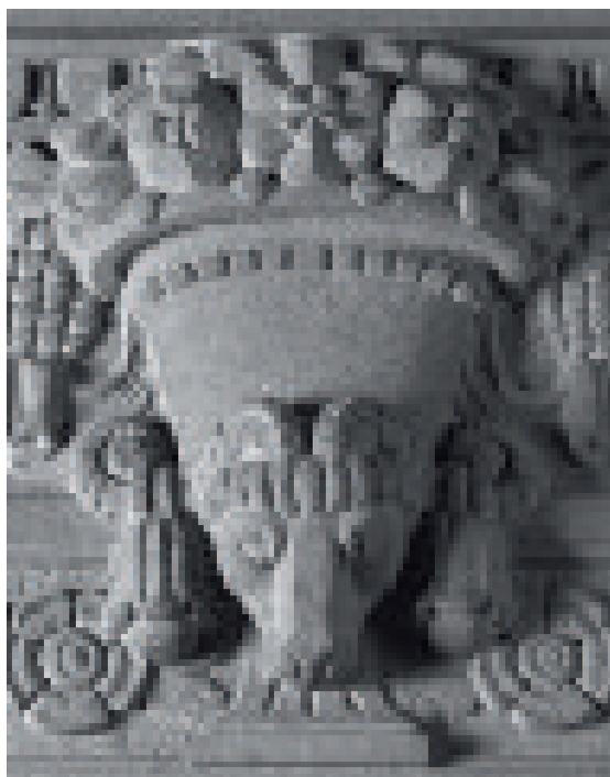
Detalle de la obra de mampostería ▼ sobre uno de los accesos de la Sala Wyndham White (Sala W).
