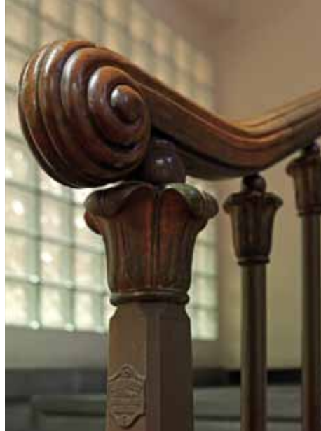
➤ Arranque de la baranda de la escalinata de la planta baja, esquina sudeste del edificio original (realización de Edmond Hess, 1926)
