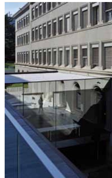
↗ Pasaje entre el Edificio Sur y el cuerpo central del Centro William Rappard
